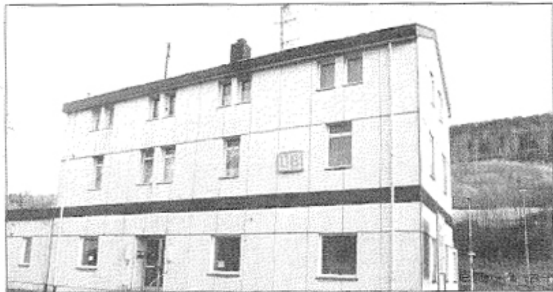
Das Bahnhofsgebäude in Oberkochen: Vor dem Umbau zum Café – Warten auf Fördergelder aus Stuttgart. (Foto: ls)
