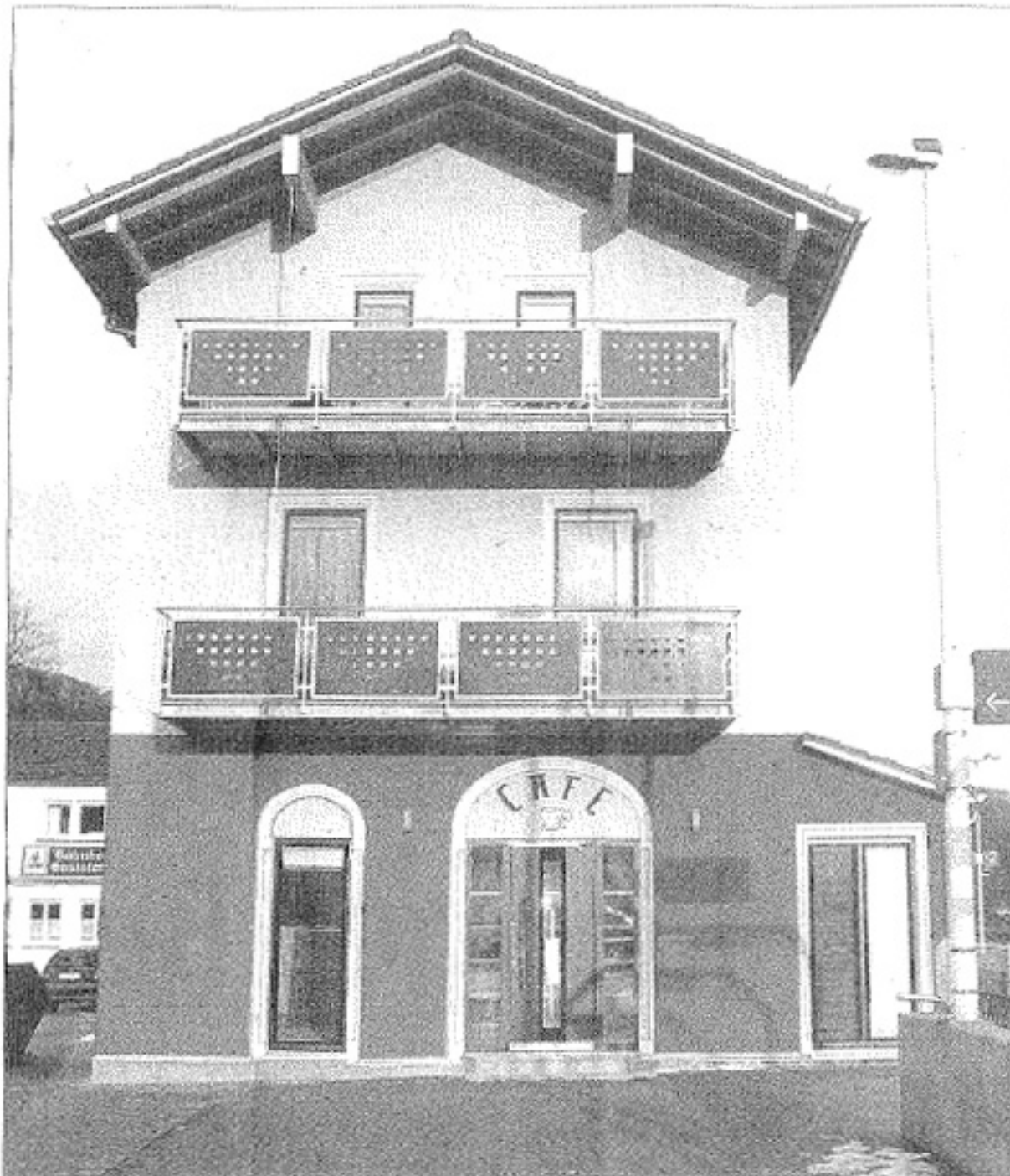
Im April soll das neue Bistro im Oberkochener Bahnhof eröffnen. Der Umbau des Gebäudes ist damit im Zeitplan. (Foto: Lothar Schell)
