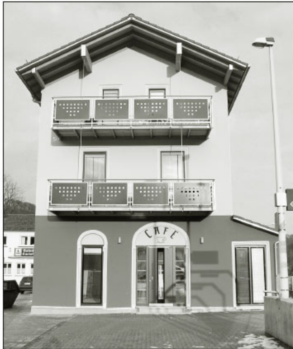
Im umgebauten Bahnhofsgebäude eröffnet das „Café/Bistro am Gleis“. (Fotos: Is)
