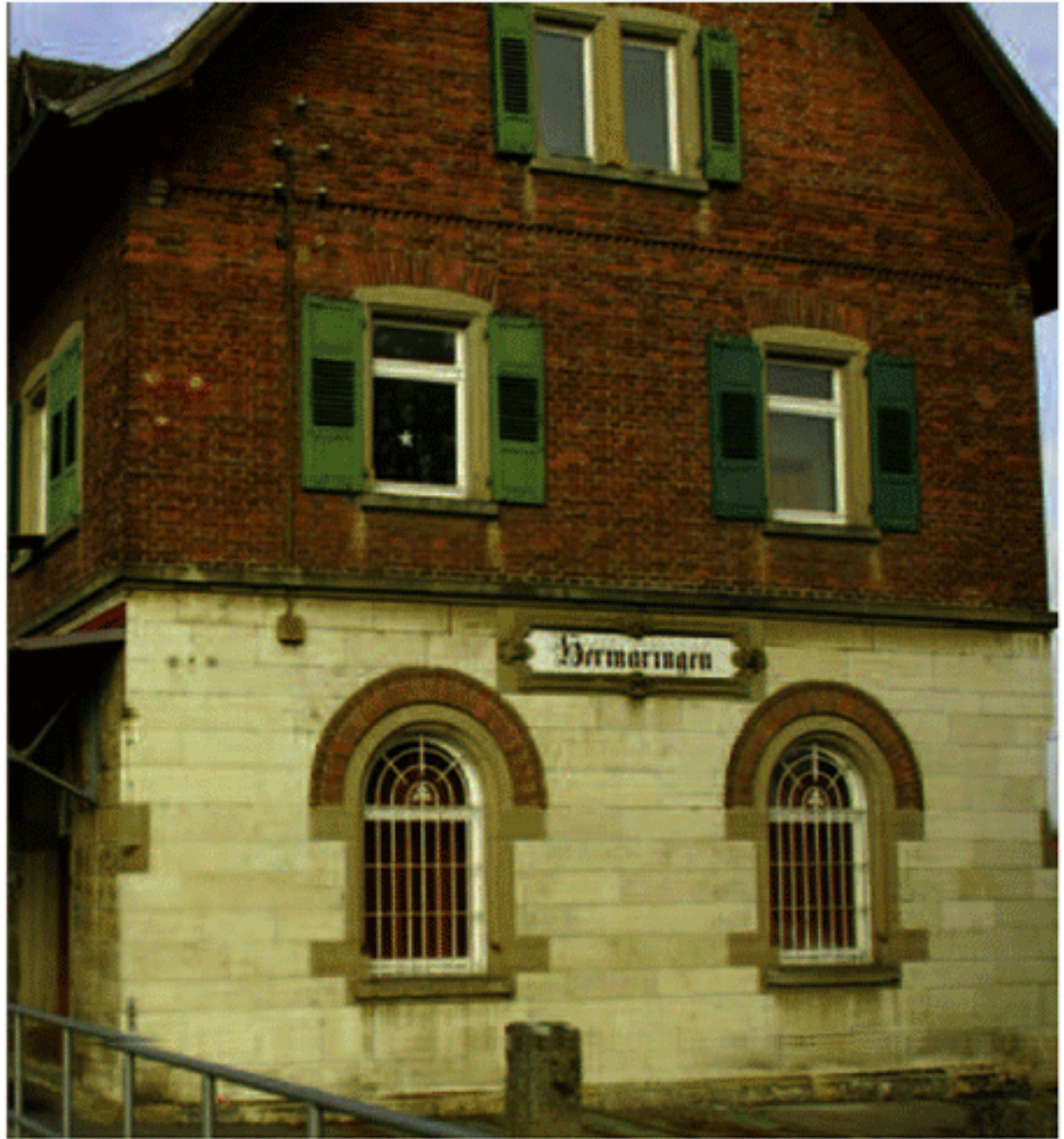
... funktionieren mittlerweile auch ohne Bahnhöfe, von denen sich die Bahn AG trennt.
