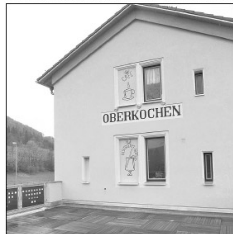
Der Bahnhof Oberkochen wurde für rund 350 000 Euro umgebaut. (Fotos: ls)
